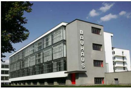
Le Bauhaus de Dessau Architecte Walter Gropius 1925
