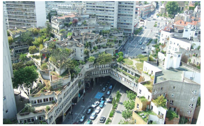
[10] Vue aérienne des Étoiles de Jean Renaudie, rénovation du centre ville d'Ivry-sur-Seine
