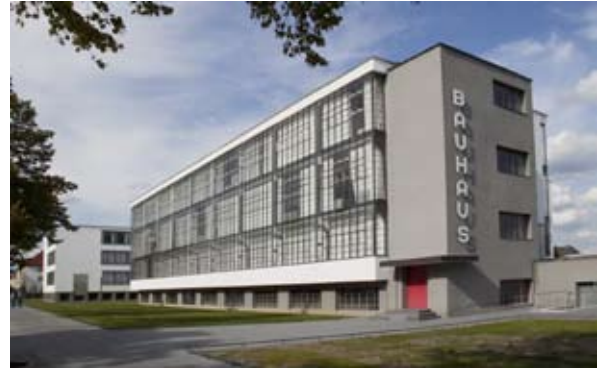
Walter Gropius, Bauhaus Building, Dessau, Allemagne, 1926
