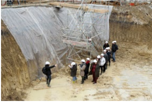
Visite d'une excavation en cours par Lara Almarcegui, Ivry-sur-Seine, 2013
